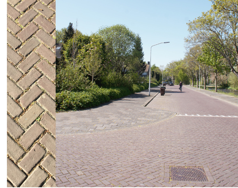
STRAATBAKSTEEN (HERGEBUIK) Keiformaat, hergebruik uit rijweg fase 1 en 2 keperverband
