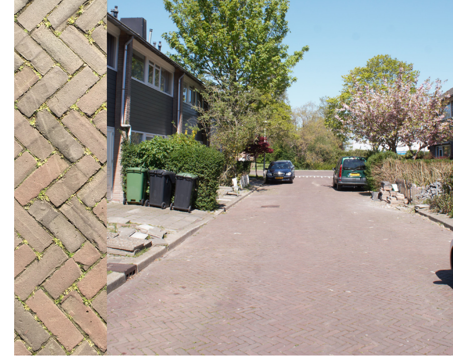
STRAATBAKSTEEN (HERGEBUIK) Dikformaat, hergebruik uit rijweg fase 1 en 2 elleboogverband
