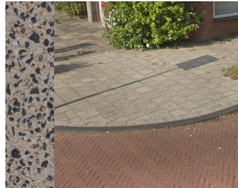
BETONTEGEL 30x30x8/5cm met vellingkant, Struyk Verwo, kleur: Lavarò Grijs 402 halfsteensverband haaks op de looprichting
