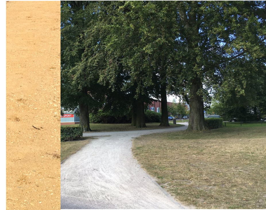
HALFVERHARDING STABILIZER GRIJS Stol, laagdikte 10cm met daaronder menggranulaat laagdikte 25cm; sortering 0/31,5
