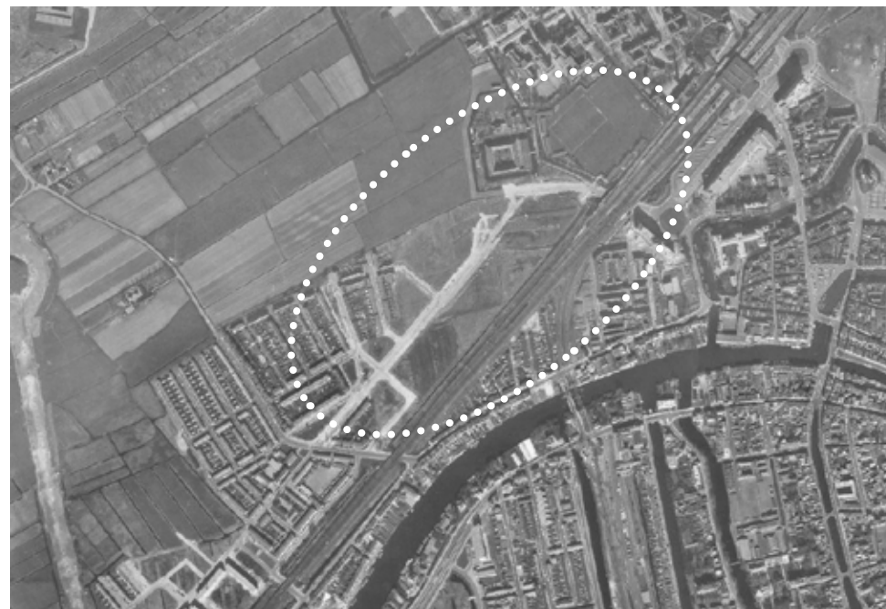
Jaren '60; aanleg Vondellaan.
