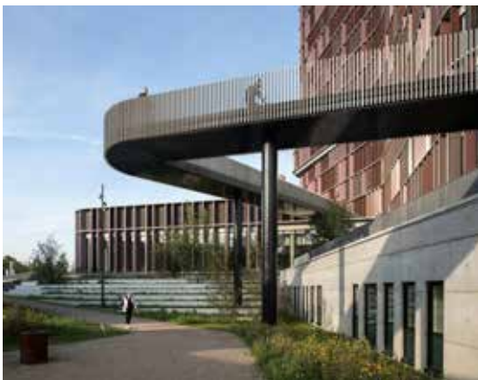
Voorbeeld van een viaduct
