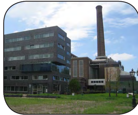
(...) een openbaar park, de gebouwen openen zich naar het park.
