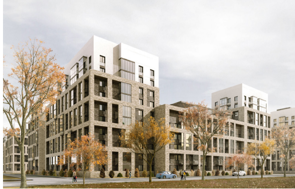
Onderscheidende bovenste bouwlagen
