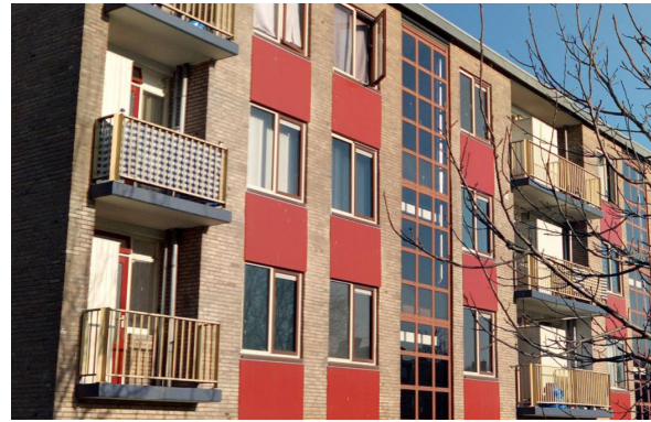
Bestaand: loggia's met balkons en verticale geleding
