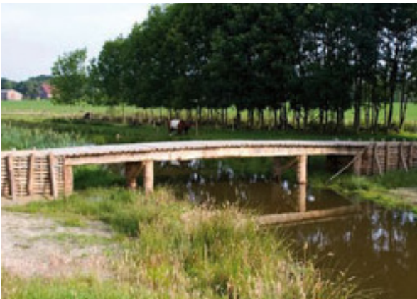
Replica Romeinse brug over Tungelroyse beek
