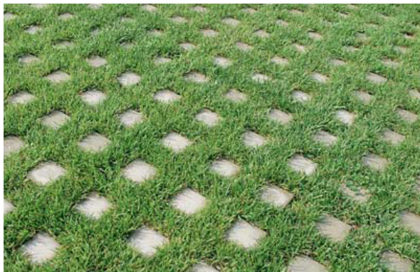
Halfverharding: waterdoorlatend en groen
