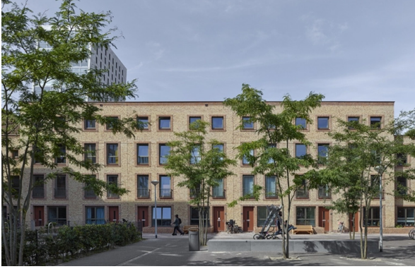
alzijdige baksteenarchitectuur: entrees rondom en dakrand
