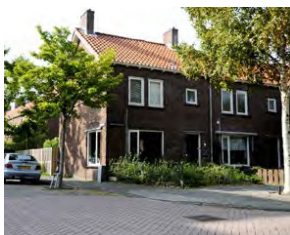
Gevarieerde woningen in een sobere baksteenarchitectuur
