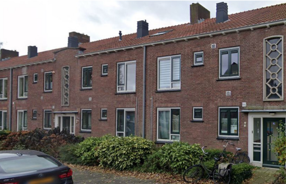
Lekstraat Leiden: Spiegelen gevelindeling zorgt voor een grotere eenheid, uitzondering dakrand in midden van rij.
